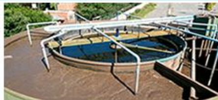
Lodos en plantas de tratamiento
